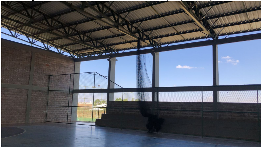
Figura 5- Abertura lateral em toda a sua extensão sem proteção a intempéries
