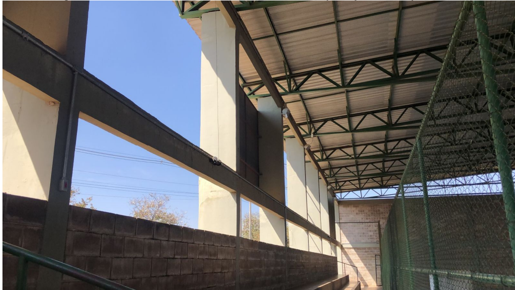
Figura 7- Abertura lateral em toda a sua extensão sem proteção a intempéries
